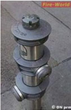
Seit 1. Juni 2007 sind nun auch Überflurhydranten „europäisch“. Grundlage dafür ist die neue ÖNORM EN 14384. Sie legt die Mindestanforderungen und Prüfverfahren, die Kennzeichnung und die Konformitätsbewertung für Überflurhydranten für Feuerlöschzwecke fest. Sie gilt für Hydranten für Trink- und Nichttrinkwasser sowie für gefiltertes Wasser.
